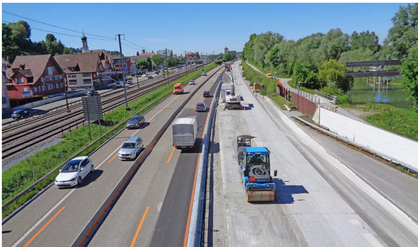
Strassenarbeiten auf der Autobahn A1/A13 Rheineck - St. Margrethen
