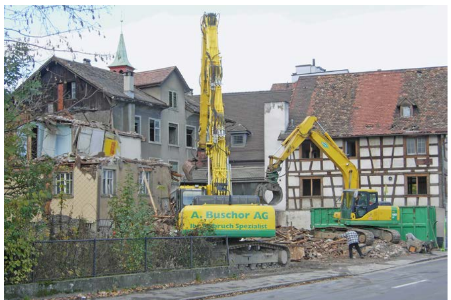
Abbruch des alten Kronenareals
