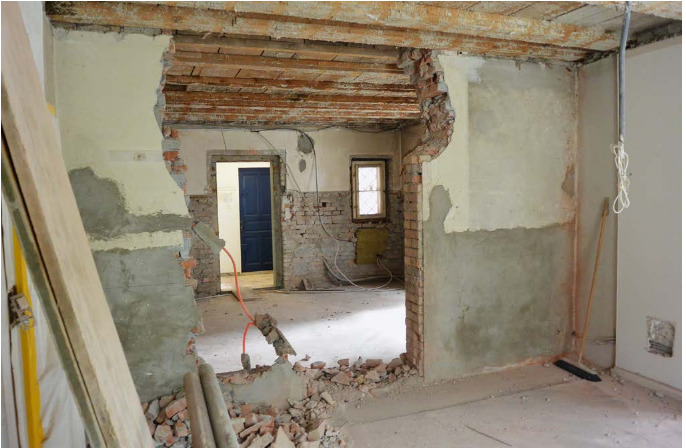
Umbauarbeiten im Rathaus Rheineck
