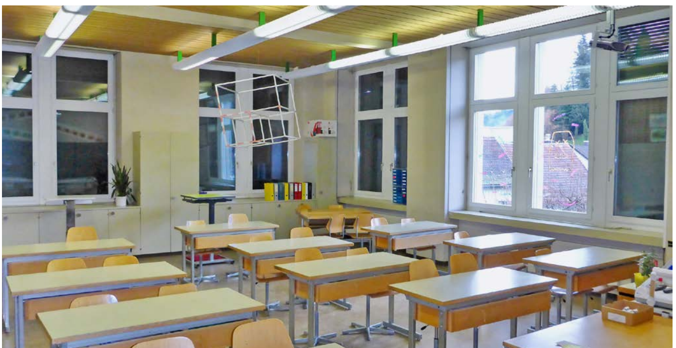
Das Oberstufenschulhaus Kugelwis in Rheineck wird über die Sommerferien saniert
