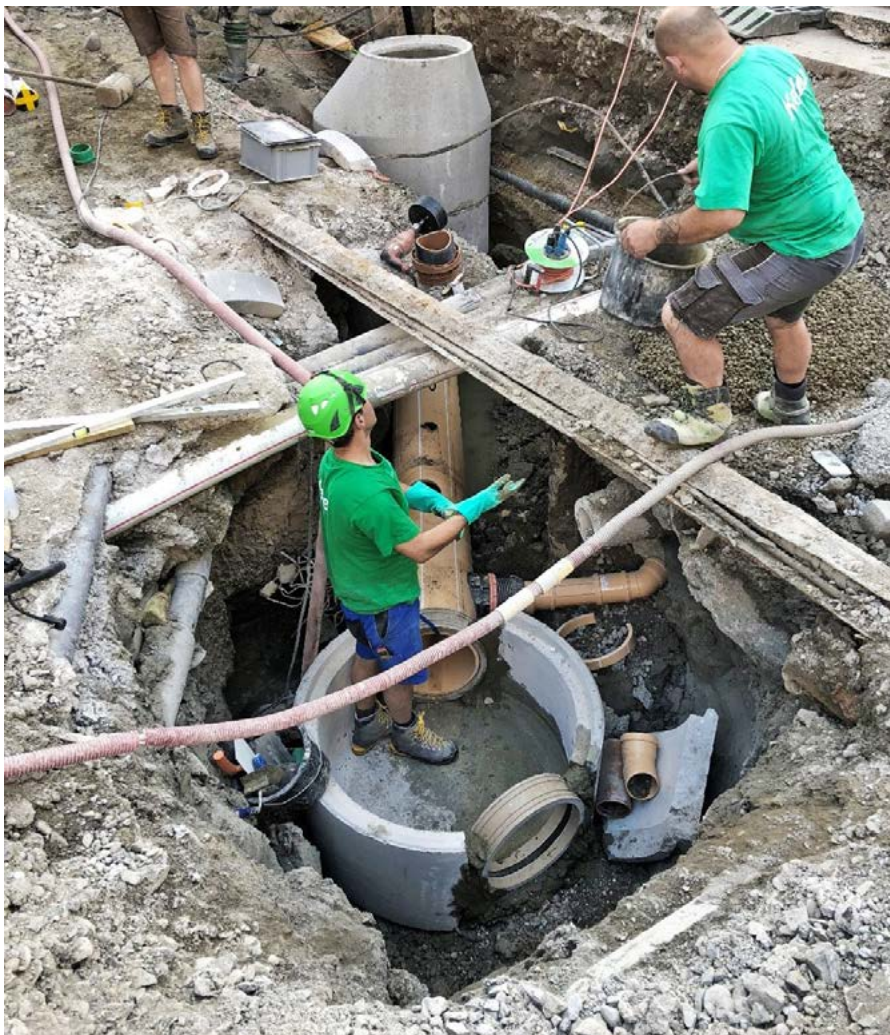
Der Werkleitungsbau in der Rhytorgasse ist abgeschlossen
