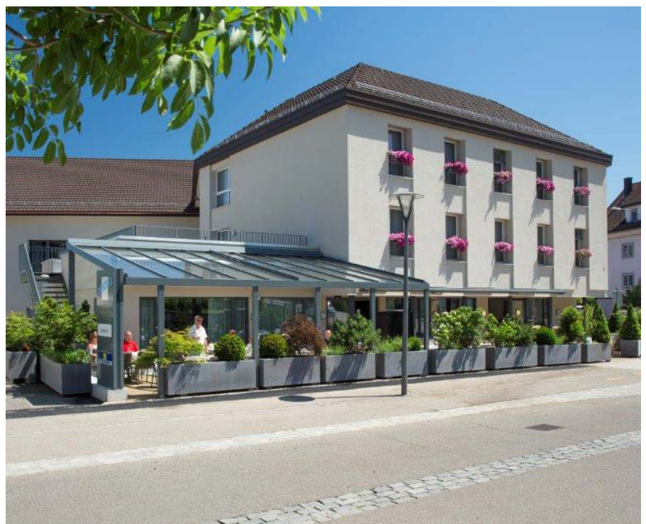
Das Hotel Hecht wird brandschutztechnisch nachgerüstet
