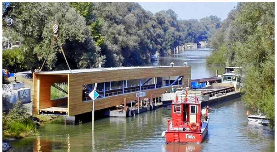
Vor 20 Jahren wurde die mit Lärchenholz verschaltete Brücke per Lastschiff auf dem Alten Rhein zum Standort gebracht.
