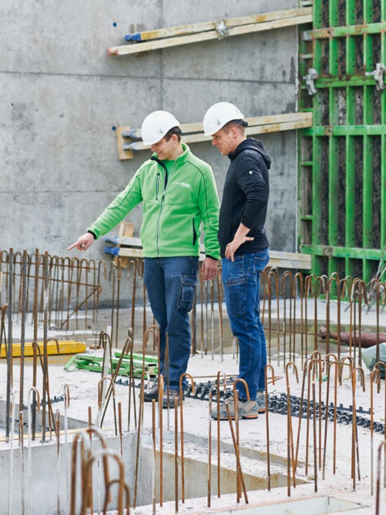
Trotz hohem Zeitdruck beschert der Bau des neuen Stadler-Produktionswerks Michael (links) und Andreas Keller keine schlaflosen Nächte.
