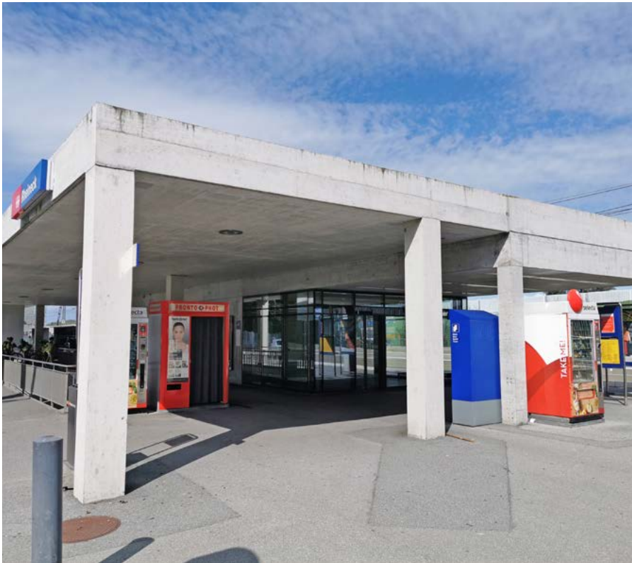
Aus dem ehemaligen Schalterraum soll kein Wartesaal entstehen.
