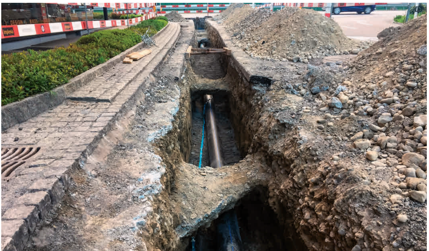
Die neuen Wasserleitungen wurden bereits eingebaut.
