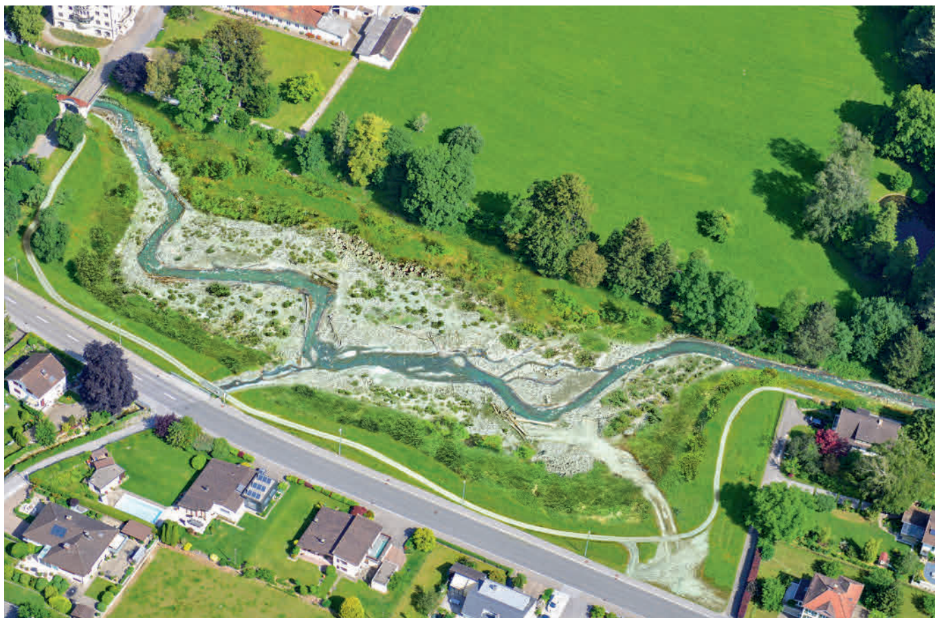
Der Geschiebeablagerungsplatz Sefar gehört zu einem der drei Teilbereiche über die die Mitwirkung eröffnet wurde.
