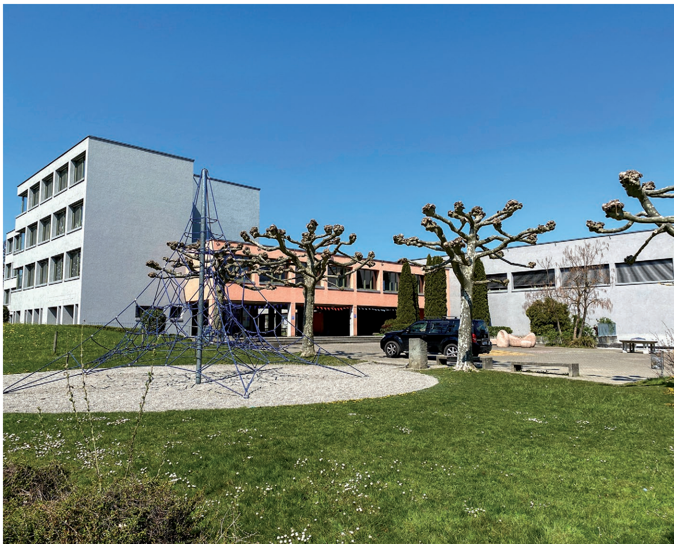
Die Arbeiten für die Dachdämmung und die Erstellung der Photovoltaikanlage auf dem Schulhaus konnten nun definitiv vergeben werden.
