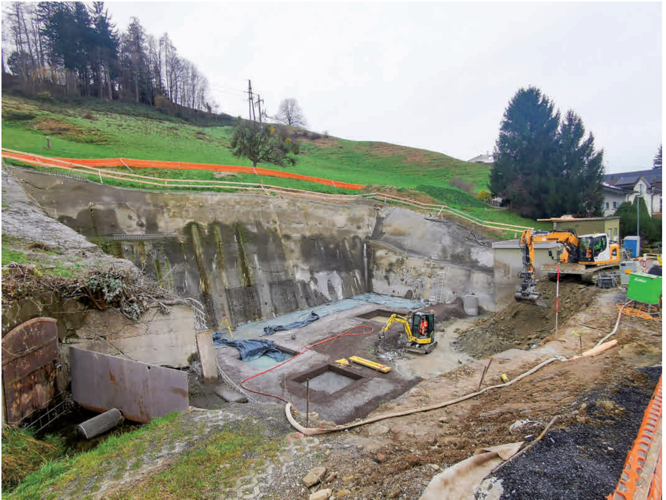
Die Aushubarbeiten des Reservoirs Altensteig sind mittlerweile abgeschlossen worden.
