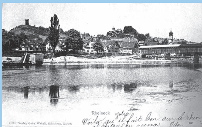
Nach dem Durchstich war wegen der geringen Wassermenge kaum mehr von einem Fluss die Rede.
