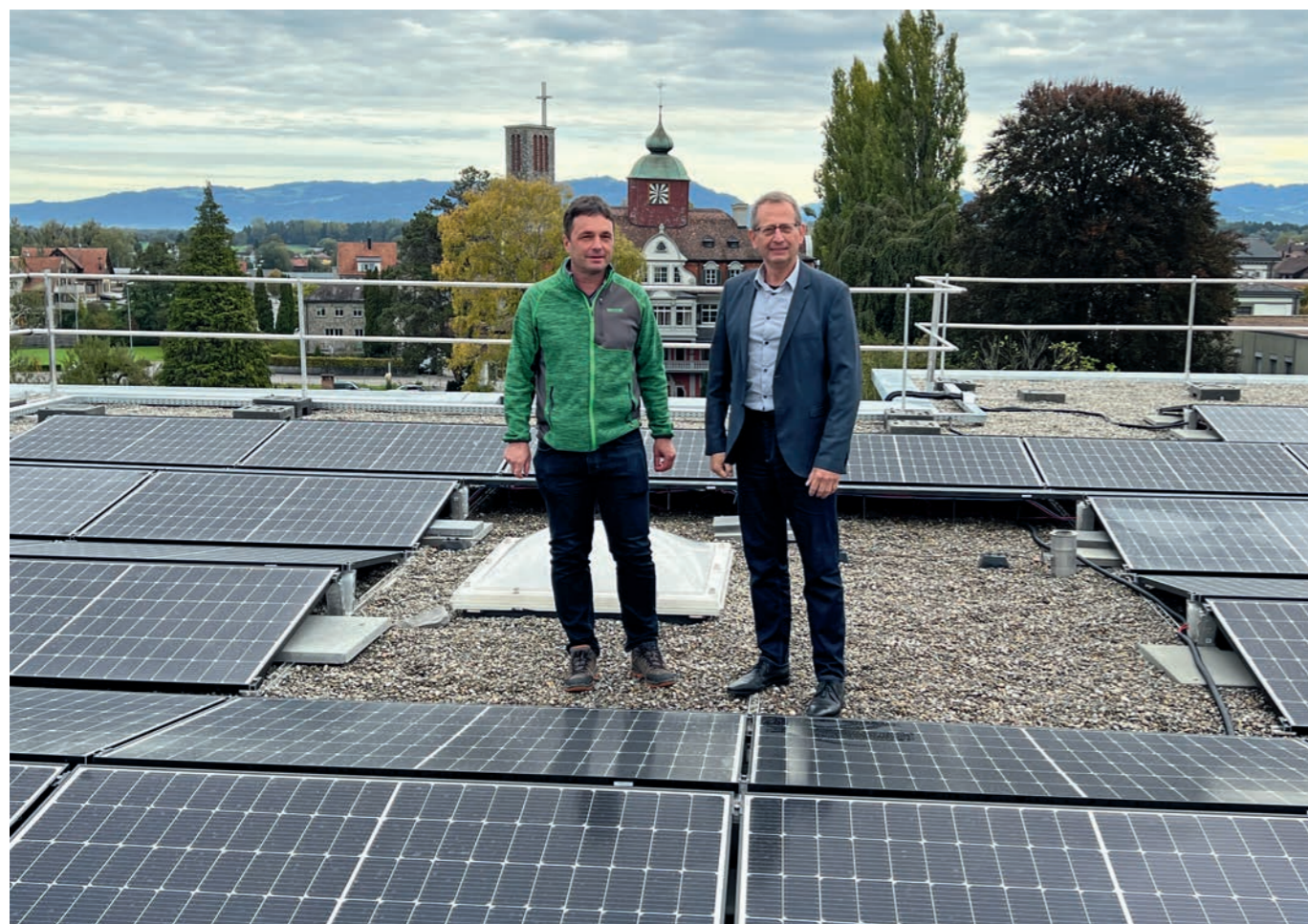
Der Leiter der Abt. Bau/Werke, Markus Heil und Stadtpräsident Urs Müller bei der Besichtigung der neuen PV-Anlage auf dem Neumüldach.
