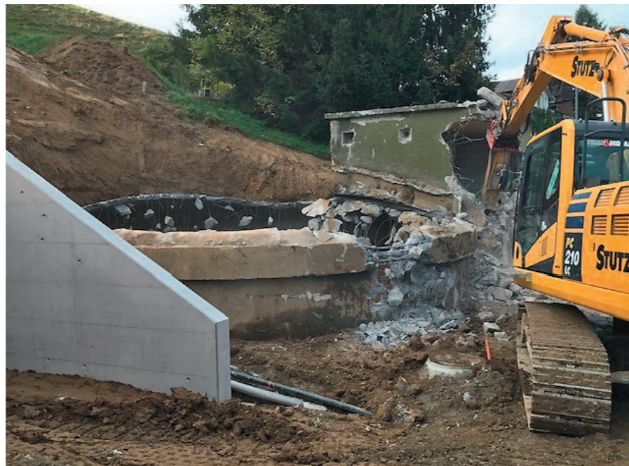
Die Abbrucharbeiten sind in vollem Gange.
