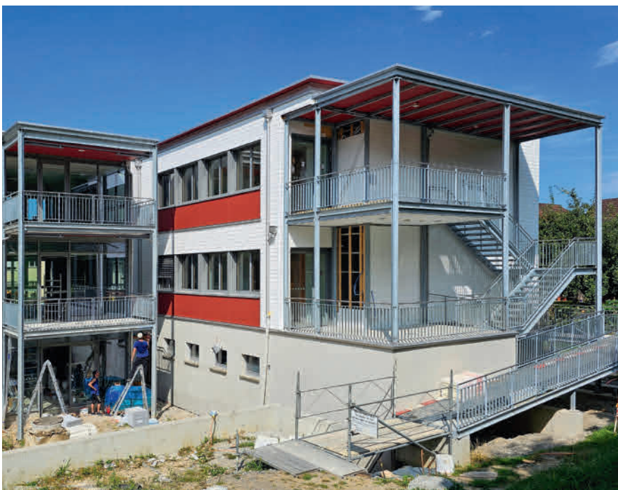
Umbauarbeiten in vollem Gange: Pflegeheim Krufft.
